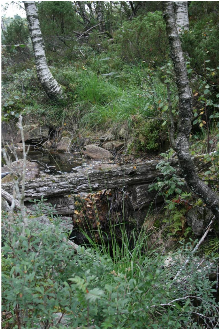
Figur 3. Dam i utløpet av Ljosevatn.
