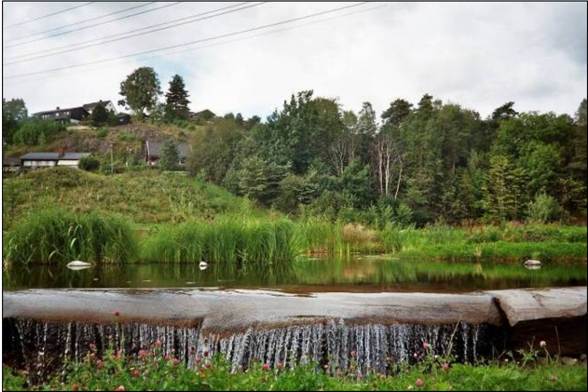
Figur 6 Detalj fra sørøst, vannfall over granittsua (foto: Kirsten Marthinsen).
