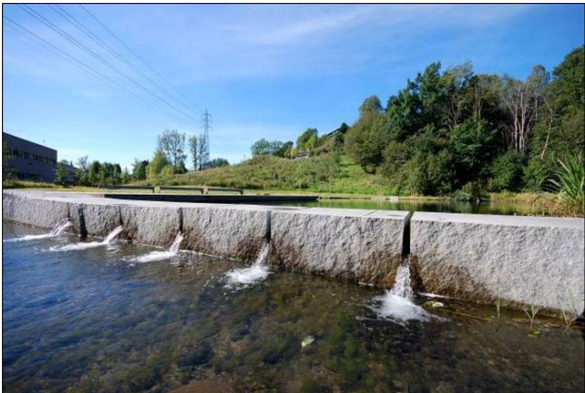
Figur 12 Demning med overløpsrenner (foto: Jon Museth).
