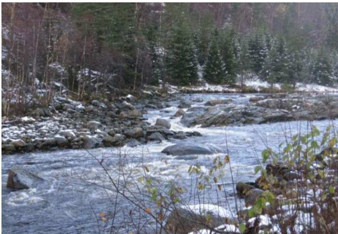
Figur 5. Terskelen ved Sagja ved vannføring på om lag 22 \text{ m}^3/\text{s} . Bildet viser vestre løp til venstre, hvor terskelen er lav. Foto: Lars J. Gjemlestad
