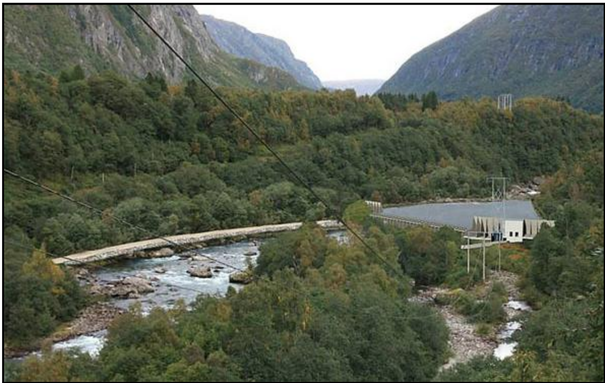
Figur 2. Visualisering av planlagt langtidssperre i Snøvasfossen med indikering av areal som blir neddemt oppstrøms sperrestedet (til høyre i bildet). Bildet er tatt fra sørsida og mot strømrretningen av elva. Figuren er hentet fra rapporten til Bergen med flere (2012) og er gjengitt med tillatelse fra Per Ivar Bergen i Sweco AS.
