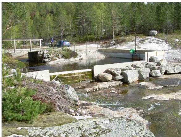
Figur 12. Åsevatnet. Hekkehistorikk (øverst til venstre), beliggenhet (øverst til høyre), etter oppdemning i 2009 (til venstre) og situasjonen i 2011 hvor det tydelig er blitt et strømparti under og nedstrøms brua etter at terskelen ble senket.
