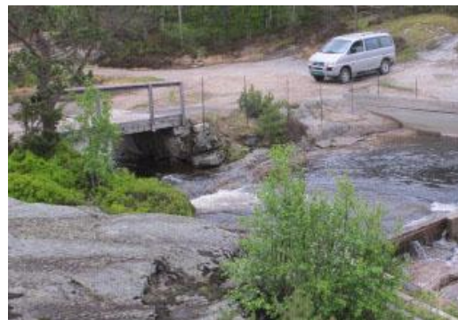
Figur 12. Åsevatnet. Hekkehistorikk (øverst til venstre), beliggenhet (øverst til høyre), etter oppdemning i 2009 (til venstre) og situasjonen i 2011 hvor det tydelig er blitt et strømparti under og nedstrøms brua etter at terskelen ble senket.
