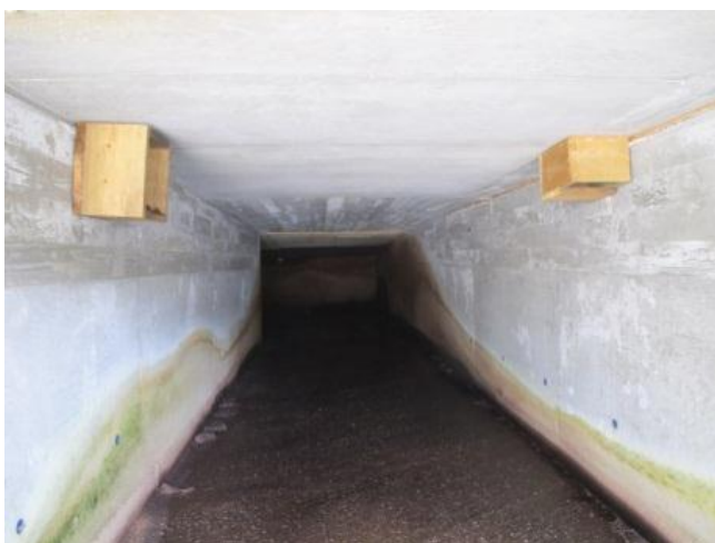
Figur 6. Eksempel på stor og liten kasse inne i utløpstunnelen for Bergesli småkraftverk.
