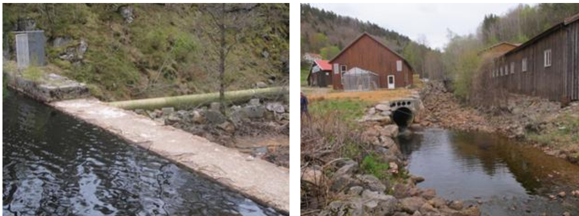
Figur 8. Inntak (til venstre) og utløpstunnel ved Trædal småkraft.
