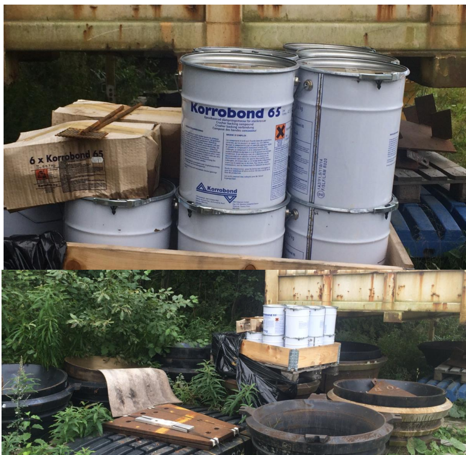
Figur 74. Opplagring av miljøfarlig avfall nært inntill Skårvollbekken. Korrobond 65 (både komponent A og B) er iht. «Safety Data Sheet» for stoffet klassifisert som skadelig for akvatiske organismer, med potensiale for negative langtidseffekter på vannmiljøet.
