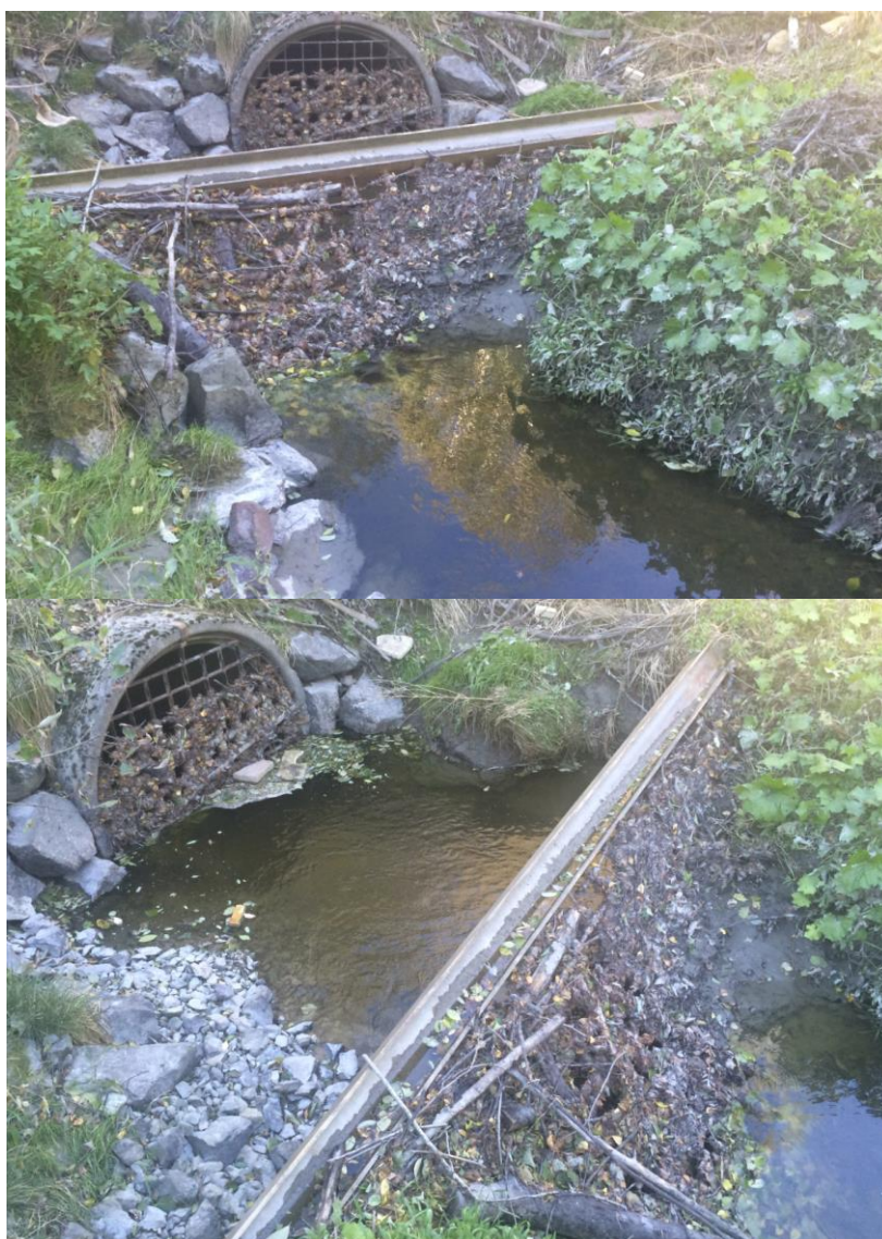
Figur 15. To rister foran jernbanekulverten går tett, og gir ingen muligheter for forbivandring for sjørret. Ristene må fjernes eller endres. Det demmes opp til stillestående vann langt oppover bekken. Det er uklart om også selve kulverten også kan være et problem. Inngrepet er tiltakspiktig iht. vannforskriften, og avgjørende for at miljømål i Langbekken skal oppnås.
