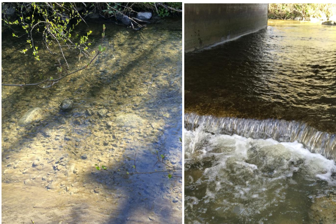
Figur 3. Nedslamming i Eggbekken er et problem (t.v.), og ikke optimalt utforming av veikulvert under Fv 707 representerer et ukjent problem for oppvandring av gytefisk på lavere vannføringer(t.h.).
