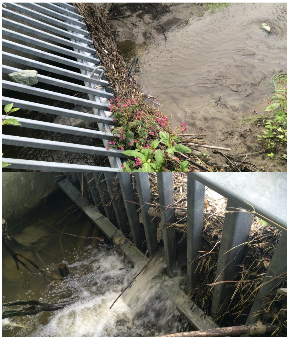
Figur 18. Ny veikulvert under Fv 735 er vandringstoppende for laks og sjørret.
