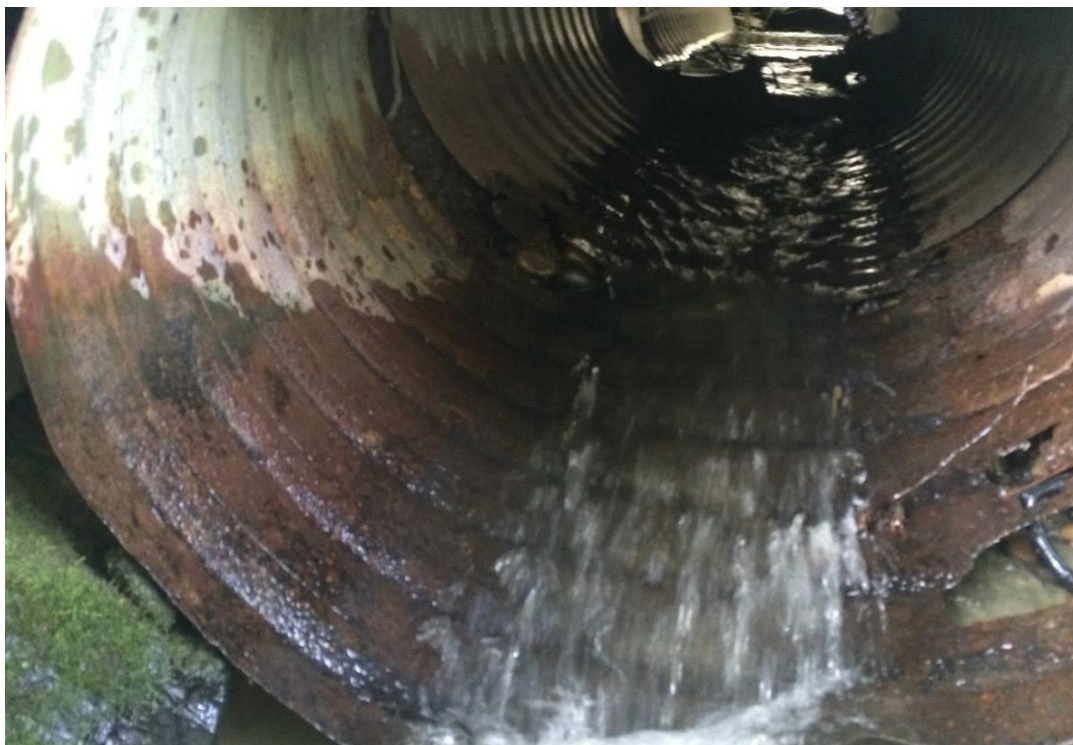
Figur 8. Ikke optimal, men passerbar, vandringsvei for sjøørret gjennom kulvert under traktorvei.
