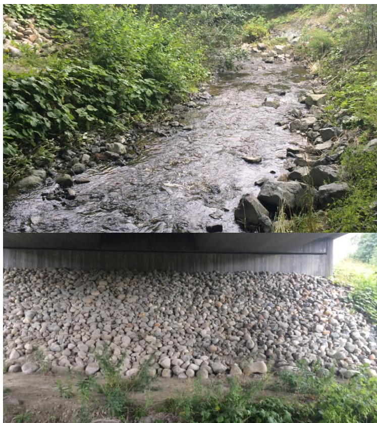
Figur 12. Utelukkende bruk av skuttstein i Ratbekkens steinsatte bekkeløp (øverst) gir liten mening og er ikke egnet for gyting for hverken sjørret eller laks, mens store mengder rund elvestein er anlagt på land (nederst) under E6-brua like ved bekkeløpet.
