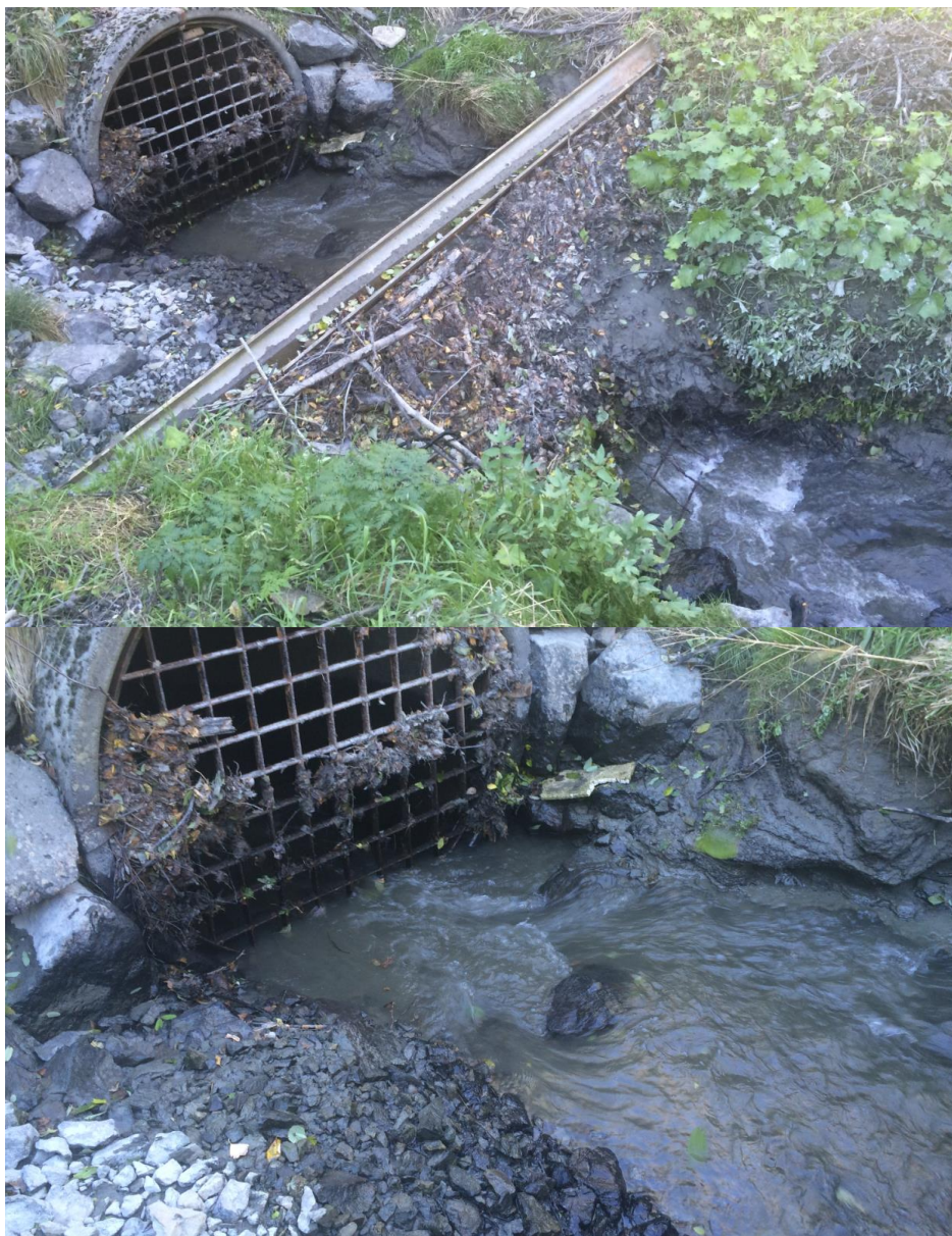
Figur 16. Situasjonen etter at NINA foretok en opprensning av rister foran jernbanekulverten. Trolig vil ristene gå tett igjen etter kort tid, og stor gytefisk kan ha problemer med små riståpninger. Varige tiltak må utføres ved jernbanekrysningen.
