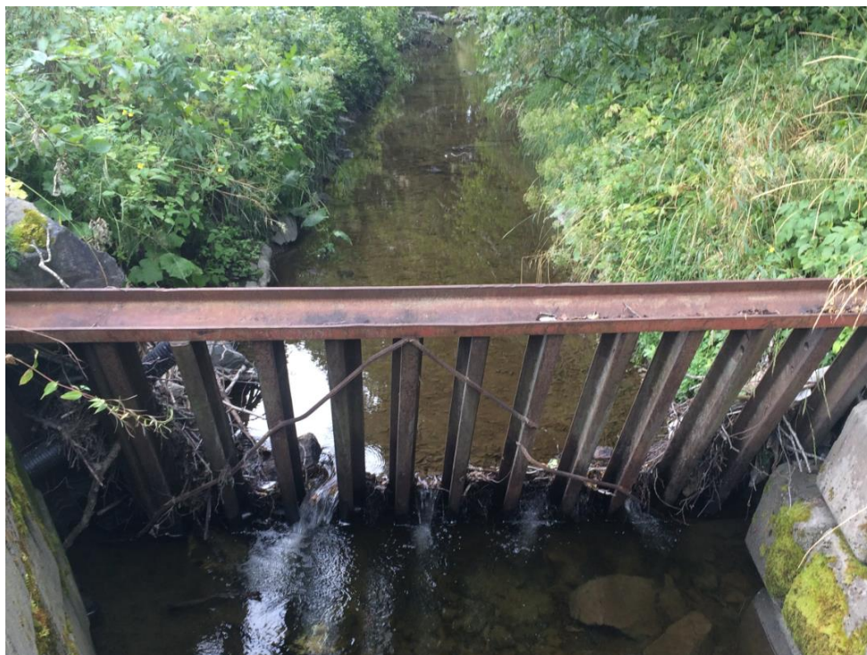
Figur 52. Rista foran jernbanekulverten bar preg av å ha blitt rensket opp høsten 2015, og for- bivandringsmulighetene var dermed bedre enn foregående år. Det påpekes at rista er for smal for stor gytefisk, og selekterer derfor på mindre størrelse for gytefisk i Ørbekken.
