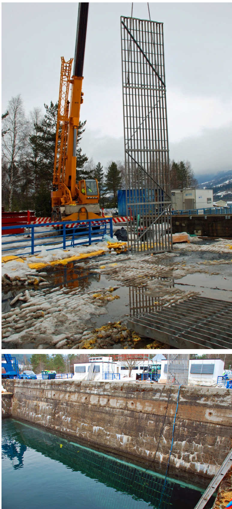
Figur 1. Øverst: Fra arbeidet med å installere de siste seksjonene til de nye varegrindene med 10 cm lysåpning. Nederst: De nye seksjonene kan sees foran inntaket (foto: Morten Kraabøl).
