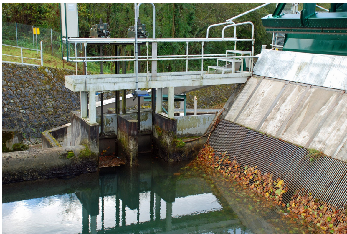
Figur 19. Eksempel på skråstilt og finmasket varegrind ved et kraftverk i Gave d'Ossau i Frankrike. Luke for fiskepassasje ligger optimalt plassert inntil varegrinda (foto: Morten Kraabøl).
