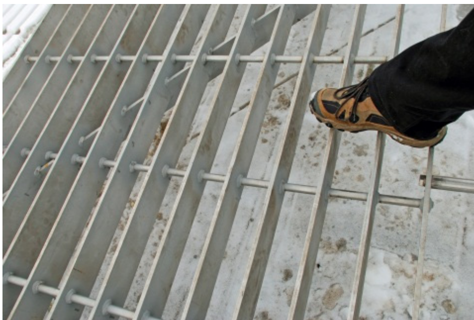
Figur 7. Element fra ny varegrind med 10 cm lysåpning ved Hunderfossen kraftverk (foto: Morten Kraabøl).
