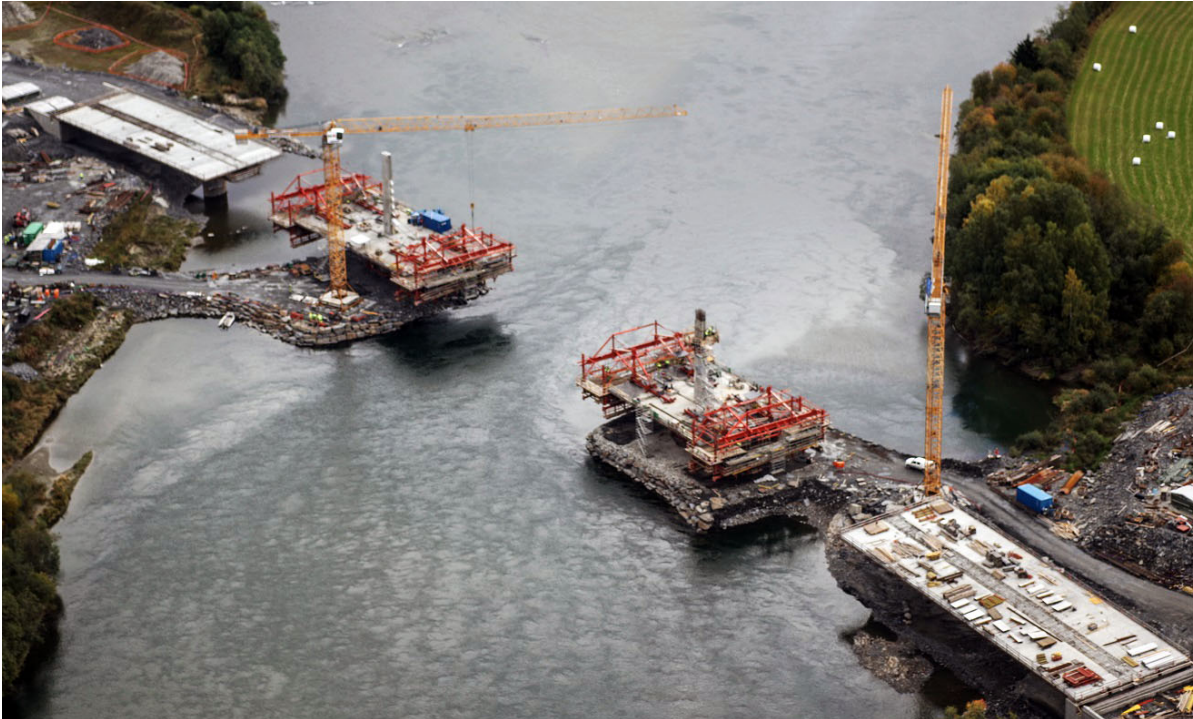
Figur 2. Flybilde av Harpe bru (25.9.2015). Det innsnevrede elveleiet ligger mellom massefyllingene som ligger rundt de ytterste brupillarene. Strømretning og dypålen går opp og til høyre i bildet.
