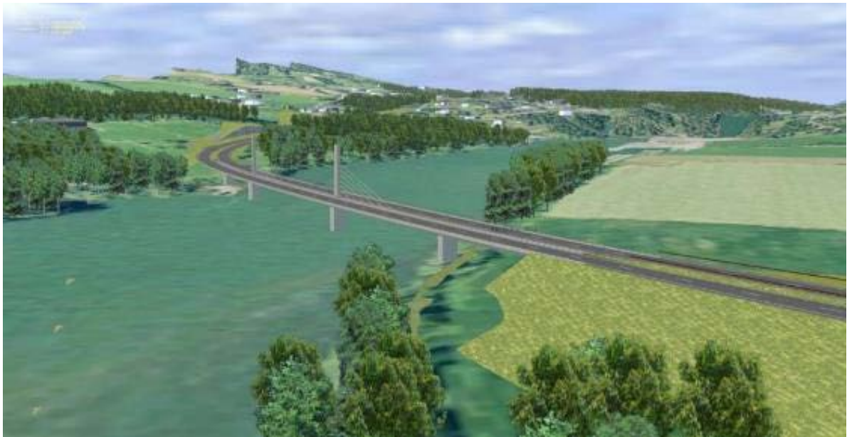
Figur 1b. Skisse av Harpe bru etter ferdigstilling. Bruspennet mellom pilarene i elvas midtparti er 100 m.
