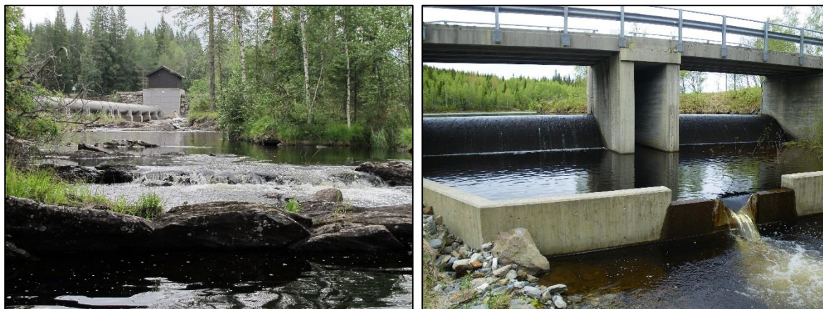
Fallselva nedenfor Linderuddammen med rørgate og slipp av minstevannføring gjennom dammen (bildet til venstre). Mossa nedenfor reguleringsdammen ved utløpet av Åfjorden med vannslipp på 0,1 m 3 /s i juni 2010 (bildet til høyre). Foto: Bjørn Mejdell Larsen.
