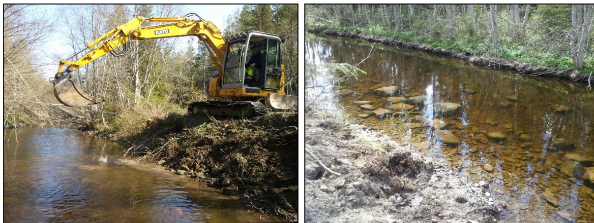
Tiltaksområdet med utlegging av stein og grus i Drakstelva i 2012. Bildet til venstre viser utlegging av masser i elva og bildet til høyre viser hvordan elvebunnen ble seende ut etter at massene var lagt ut. Foto: Rune Garberg.
