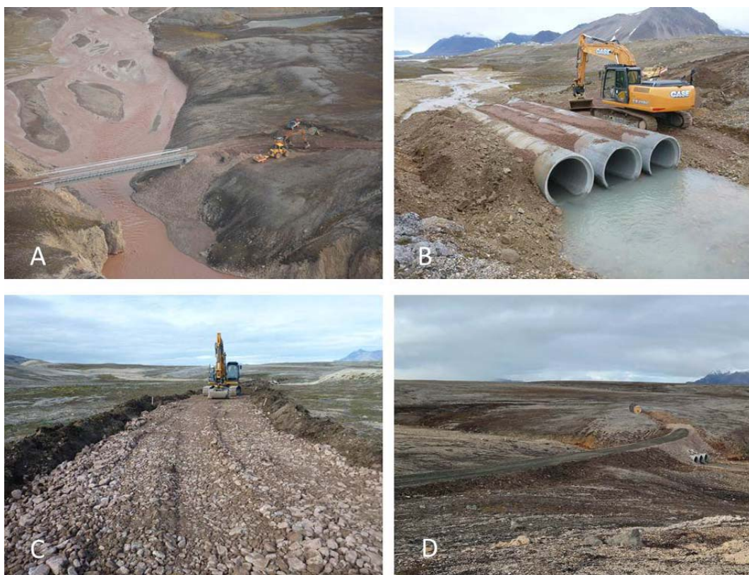
Figur 3.1. Broen over Bayelva (A) ble bygd i juni og juli, kulverten over Mørebekken (B) og vei 2 (C) ble bygd i august. Anleggsarbeidet endte rett på nordsiden av Mørebekken (D) i september. Foto: Frode Koppang.
