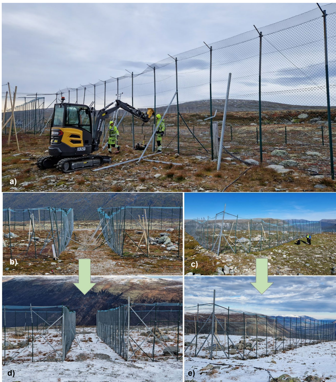
Figur 7. (a) Reparasjonsarbeid på hegn 2 i september 2022. (b, c) Eksempler på tilstanden til noen innhegninger før arbeidet ble satt i gang og (d, e) de samme hegnene etter reparasjon. Foto: Avlsprogrammet for fjellrev/NINA.
